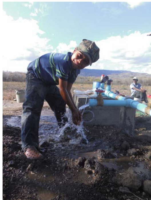
Endlich fließendes sauberes Wasser in einer Gemeinde in Nicaragua Foto: Sergio Rios Carrillo
